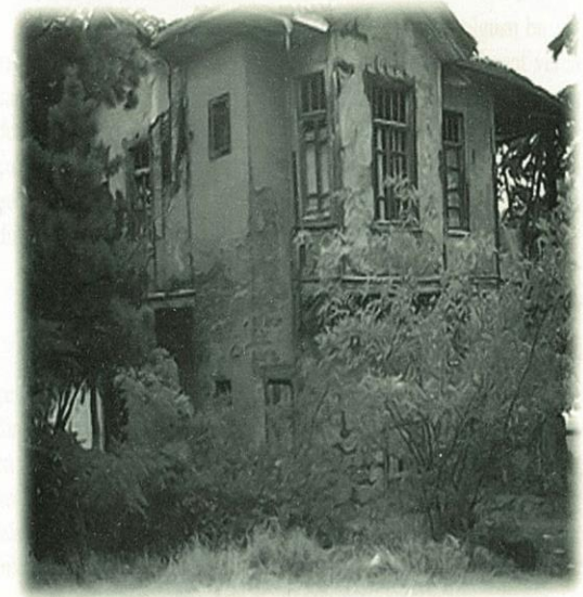
Resim 2: Keçiören'de onarıma muhtaç bir bağ evi.
